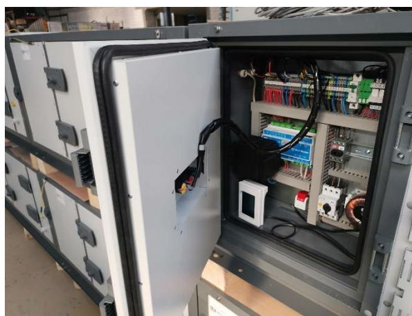
Рисунок 4. БЛОК вентиляторный с встроенным САУ.
